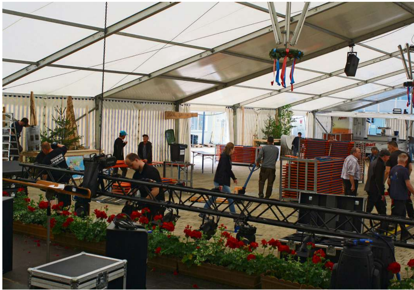
Seit Montagmorgen läuft der Abbau. Ab Mittwochmittag stehen hier wieder Autos und kein Festzelt mehr.
